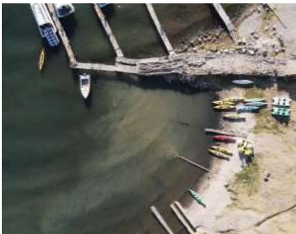
Descarga de Aguas Residuales
