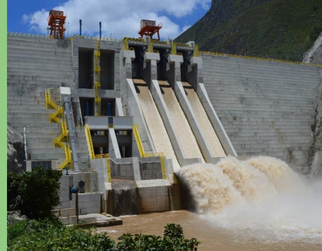
Fotografía 4. Hidroeléctrica Minas San Francisco
