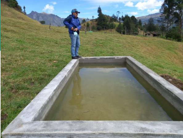
Fotografía 17. Dotación de abrevaderos
