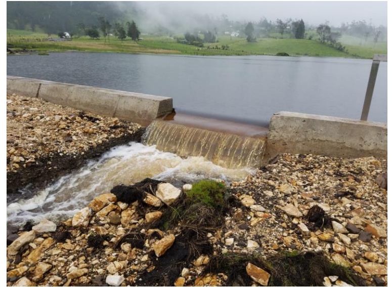
Fotografía 9. Dique en Laguna San Martín
