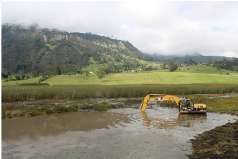
Fotografía 10. Intervención de maquinaria en laguna San Martín
