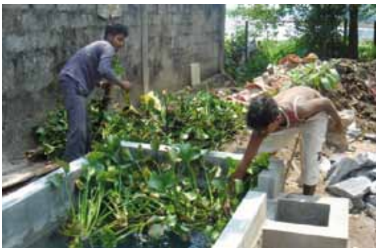
Der Bau des zweiten Umweltbildungszentrums mit modernen Pflanzenfiltern für das Abwasser wurde 2008 erfolgreich abgeschlossen.
