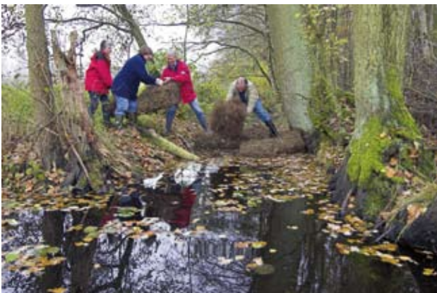
Wiedervernässung durch Anstauen der Abflussgräben mit Heidekrautballen.
