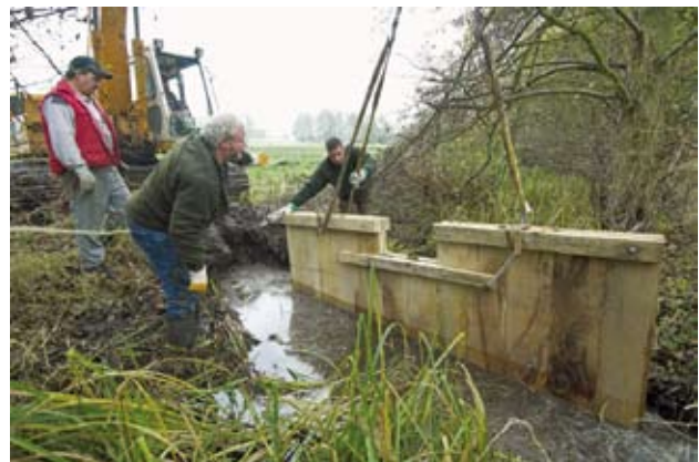
Das Einbringen der Holzbaubretter war Maßarbeit.
