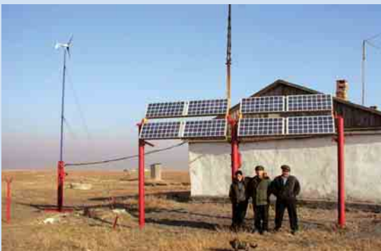
Wind- und Solarenergie am Besucherzentrum im Schutzgebiet am Tengis See
