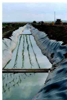
Construcción de un filtro verde.
