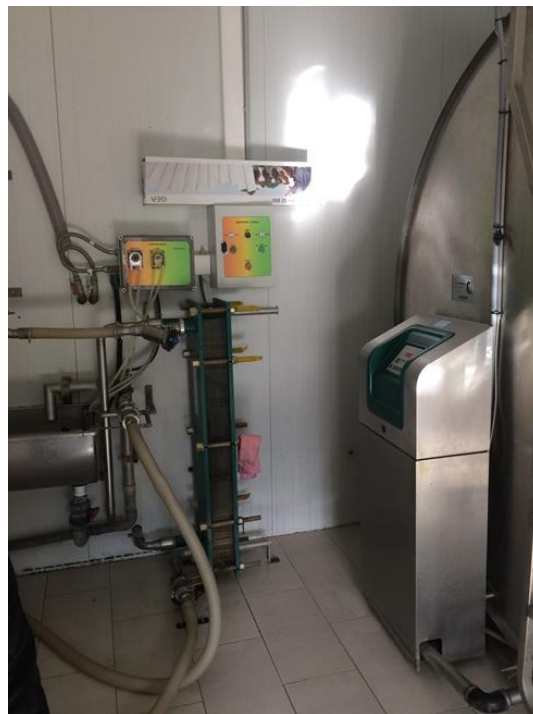
Abbildung 10: Beispiel eines Plattenwärmetauschers
